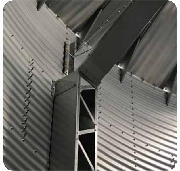
**Goulotte de déchargement.** Elle permet au produit de glisser de manière homogène lors du déchargement du silo.
