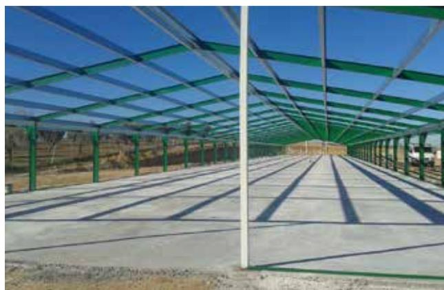
Nous nous adaptons également à tous les besoins en utilisant des profils industriels de tous les types disponibles sur le marché, tels que les profils laminés de type IPE, HEA, etc. Les profils peuvent avoir une finition galvanisée à chaud, une protection avec couche d'apprêt au caoutchouc-chlore, etc.
