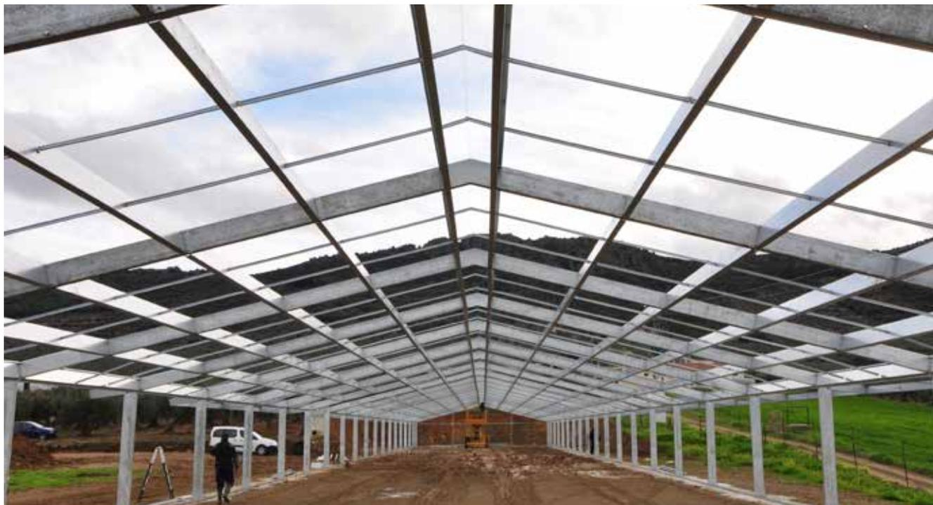
Compte tenu des besoins des installations avicoles, une édification entièrement diaphane est nécessaire pour supprimer les barrières, assurer une aération appropriée et un éclairage homogène. Comme système idéal pour répondre à ces besoins, on a conçu une structure métallique constituée de portiques et de linteaux sans appuis intermédiaires.
