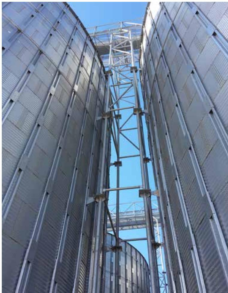
Las **torres de elevadores** son estructuras modulares atornilladas y soldadas fabricadas con perfiles laminados en doble T en acero galvanizado. Aportan estabilidad, facilitan el acceso a las pasarelas y posibilitan las tareas de mantenimiento del elevador de una forma más segura. Con piso transitable, rejillas electrosoldadas y plataformas de mantenimiento, incluyendo tensores de sujeción.
