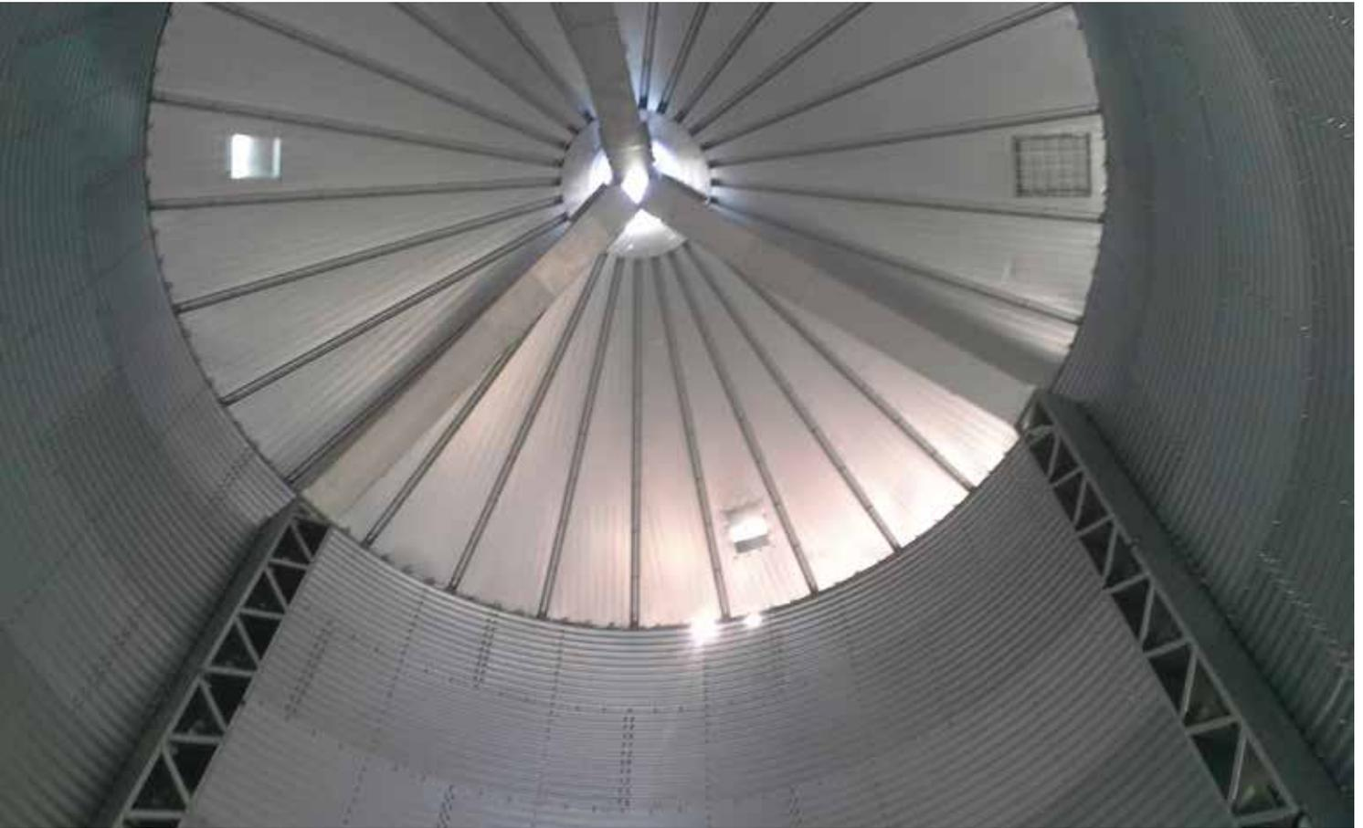
El **tobogán** es un conducto interior situado en la pared del silo que permite que en la carga (del silo) el producto se deslice de una forma homogénea, evitando así su rotura.
