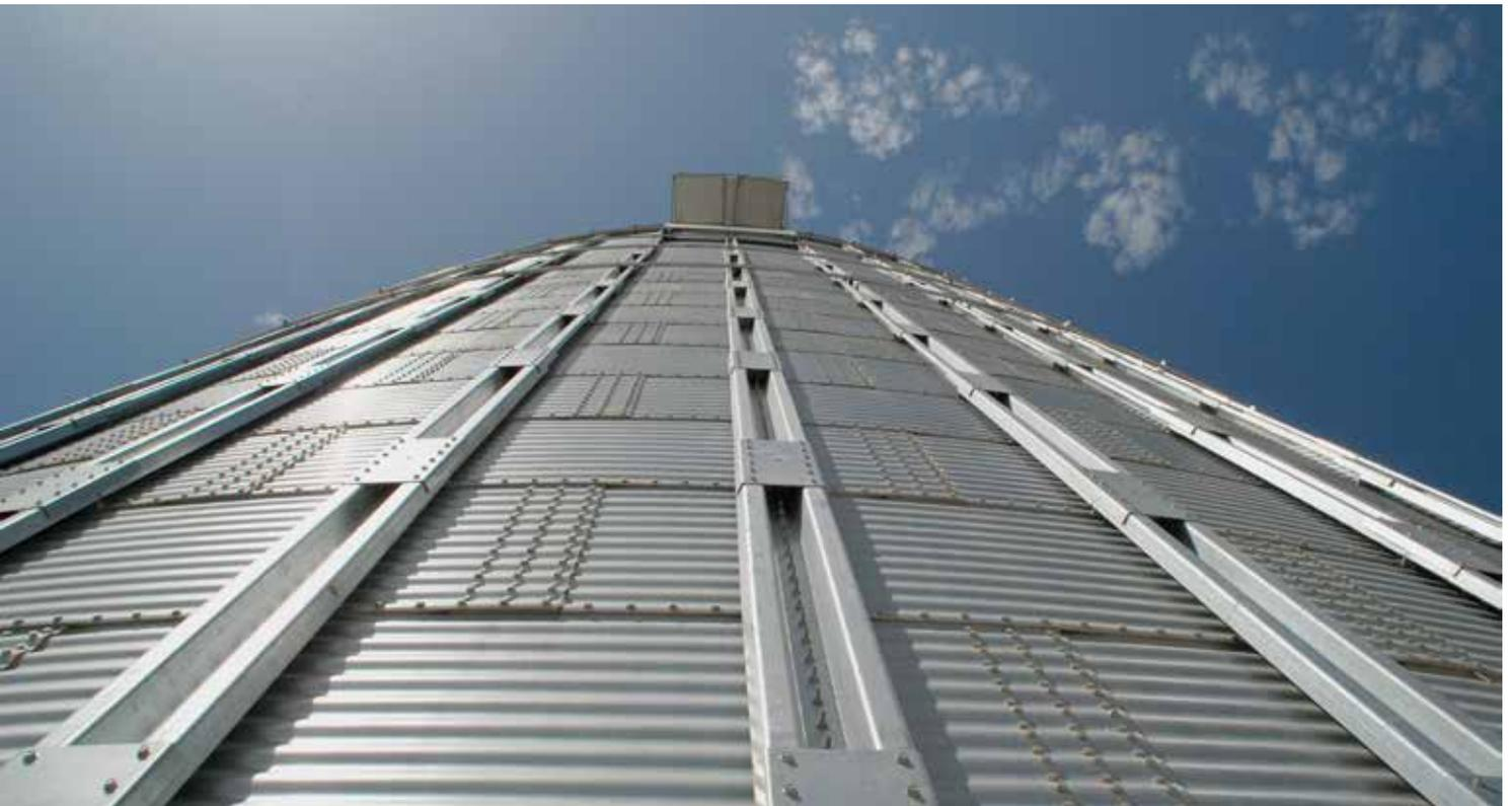
Usamos **acero de límite elástico** desde 350 MPa para virolas hasta 600 MPa para refuerzos. Silos Córdoba es la primera empresa fabricante de silos que estableció como estándar de su fabricación el acero galvanizado Z-600. Este recubrimiento supone un contenido de zinc de 600 gr/m<sup>2</sup> y equivale a un espesor por cara de 42 micras, lo que le confiere la mayor durabilidad incluso en los ambientes más agresivos (establecidos en la Norma ISO 9223).
