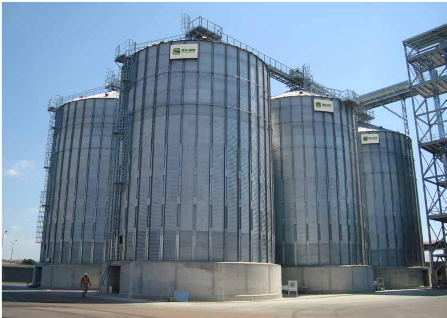
Nuestros silos asentados para base de hormigón, bien sean silos de base plana o cónica, se emplean para el almacenamiento prolongado de grandes cantidades de grano, semillas y productos granulados.
