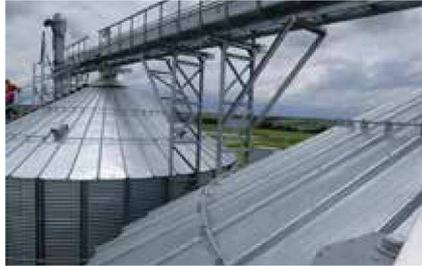
**Le support latéral** doit être boulonné aux renforts du silo. Il est employé pour une manutention légère dans des silos de jusqu'à 24 m de diamètre. En complément, il est également possible d'ajouter un support oblique au support latéral, en fonction du modèle de silo et de la passerelle.
