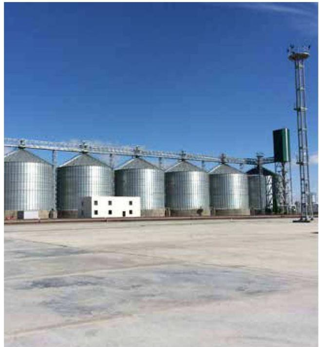
Nos silos à corps cylindrique et à plafond incliné à 30 ° sont destinés au stockage du grain, des semences et d'autres produits. L'équipe d'ingénierie de Silos Spain conçoit ses silos en suivant un ensemble de normes pour s'adapter aux besoins de ses clients, dont les normes européennes EUROCODE et la norme américaine ANSI.
