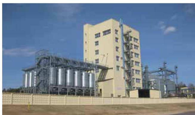
Dans les installations de type agricole, usine d'aliments de bétails ou les usines de fabrication de farine, la gamme de boisseaux de chargement disponibles présente des diamètres allant de 2,55 m à 4,65 m et des capacités allant de 11 m<sup>3</sup> à 200 m<sup>3</sup>.
