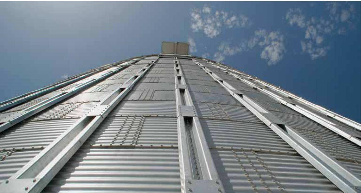
Nous utilisons de **l'acier à limite élastique** à partir de 350 MPa dans le cas des viroles et jusqu'à 600 MPa dans les renforts, avec un **revêtement métallique innovant appelé ProMag**.
