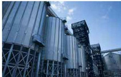
Avec ce type de silo, le cout de réalisation est réduit du fait qu'on n'aura pas besoin de la vis-balayeuse, les travaux de fondations sont simplifiés, ce qui permet aussi de réduire les coûts du génie civil et d'accélérer
