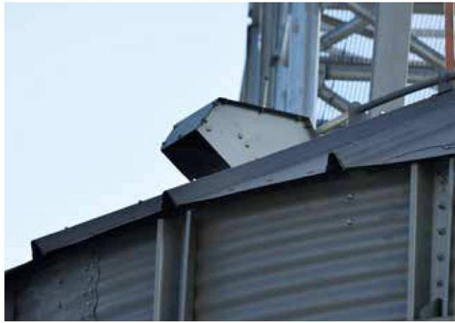
Dans le cas des installations dans des régions climatologiques extrêmes, nous vous proposons des **systèmes de protection à plafond** contre l'entrée de neige dans le silo à travers les cheminées et contre son accumulation dans les zones susceptibles d'en accumuler. Tous nos silos sont fournis avec des protections contre l'entrée d'oiseaux en leur intérieur.
