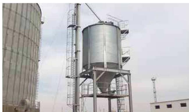
Dans les installations industrielles avec des boisseaux de chargement pour l'expédition en camion ou en train, nous recommandons l'utilisation de boisseaux de chargement d'un diamètre de 4,58 m ou plus et d'une capacité comprise entre 80 m<sup>3</sup> et 400 m<sup>3</sup>, sur demande.
