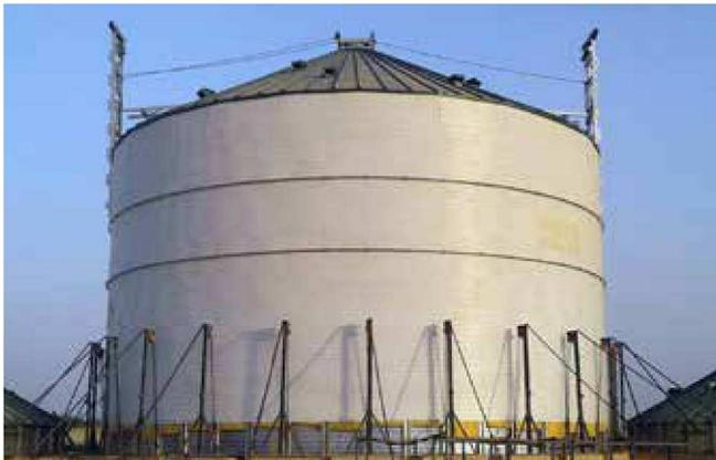
Isolation en tôle double : applicable pour le toit, pour les viroles ou pour cône. La tôle extérieure peut être prélaquée, de préférence en blanc
