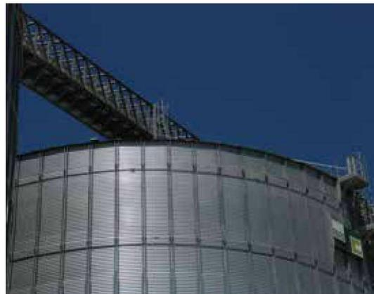
Le **Wind-Ring** permet au silo de garder sa forme cylindrique sans que les charges de vent ne puissent y influencer tout en le dotant de rigidité et de sécurité. En fonction du diamètre et de la hauteur du silo, ils peuvent être installés sur le toit ou sur la virole.
