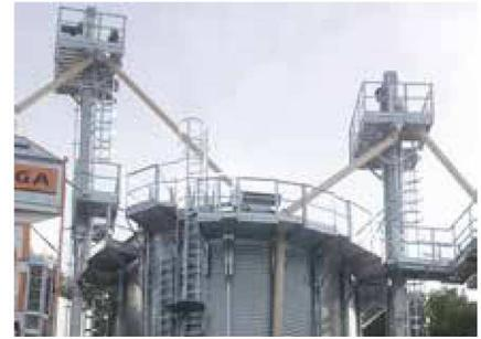
Le **périphère de garde-corps** est une structure d'amélioration de la sécurité dans le cadre des opérations d'entretien sur le toit du silo.
