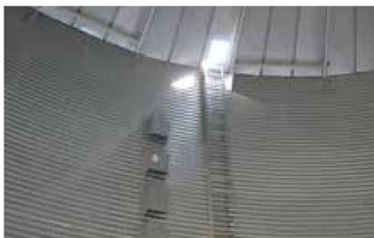
**L'échelle intérieure** du silo donne accès à l'intérieur du silo pour les opérations d'entretien et pour l'analyse visuelle des produits stockés.
