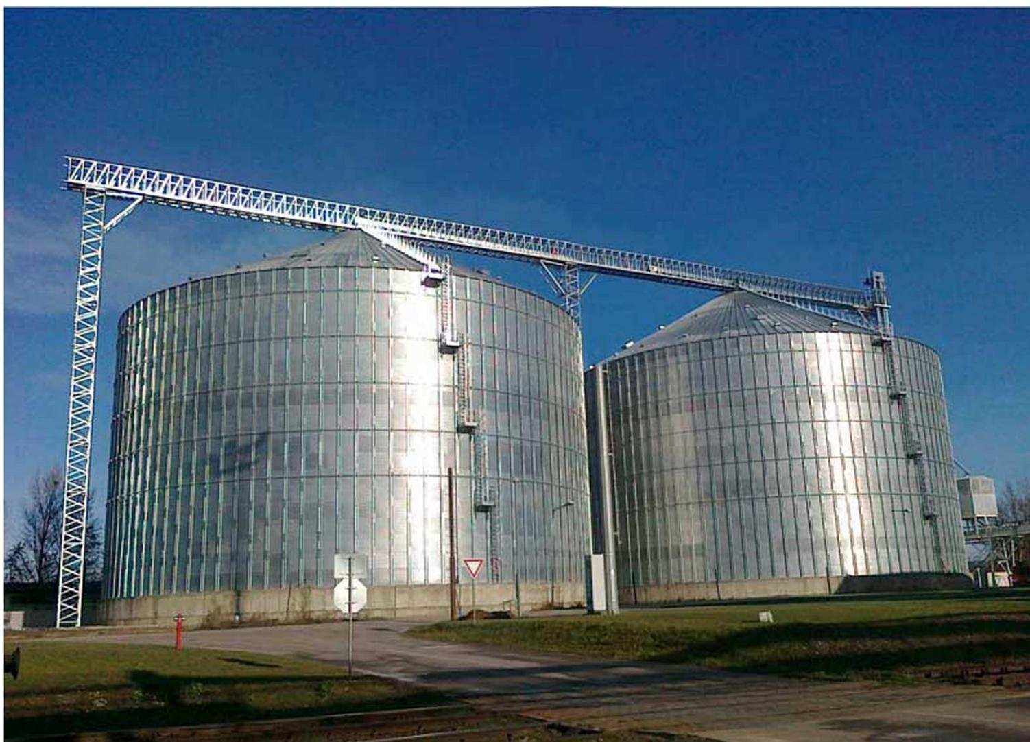
Nos silos pour base en béton, à fond plat et fond conique, sont employés pour le stockage prolongé de grandes quantités de grain, de semences et de produits granulés.
