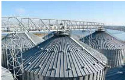
**La plateforme du dôme** est un élément fourni en option et permet de simplifier les opérations de supervision des systèmes de raccordement entre les machines employées et le silo.
