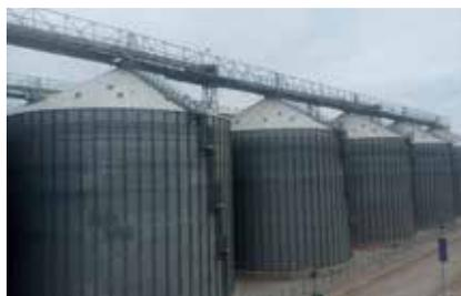
A nossa gama de silos em base de concreto apresenta capacidades que vão desde os 83 m<sup>3</sup> até 45.055m<sup>3</sup> e com diâmetros que vão de 4.58 m. a 41.25 m.
