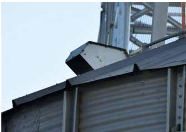
Para instalações em zonas climáticas extremas dispomos de **sistemas de proteção do teto** que evitam tanto a entrada de neve no silo pelas chaminés, como a respectiva acumulação em zonas suscetíveis. Todos os nossos silos têm proteções integradas para evitar a entrada de pássaros no interior do silo.
