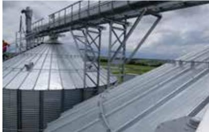
**O suporte lateral** é aparafusado aos reforços do silo. É utilizado para maquinaria leve em silos de até 24 m de diâmetro. Adicionalmente pode ser acrescentado um suporte oblíquo ao suporte lateral dependendo do modelo do silo e da passarela.
