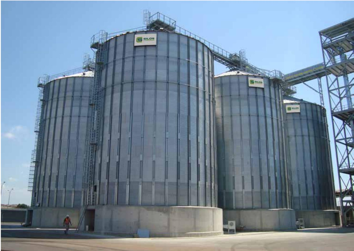
Os nossos silos de fundo plano em base de concreto, sejam eles de base plana ou cônica, são utilizados no armazenamento prolongado de grande quantidade de grão, sementes e produtos granulados.
