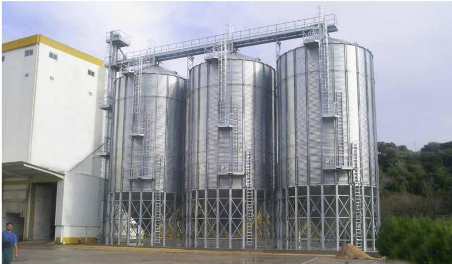
Foram concebidos para armazenamento de cereais, sementes, leguminosas, peletes e outros produtos que requerem condições especiais de armazenamento. O produto armazenado fica isolado do solo, evitando assim a umidade e diminuindo a ruptura do grão.
