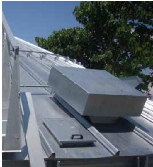
Os **extratores** são um complemento da ventilação para ambientes tropicais ou produtos propícios à condensação. Dispomos de ventiladores axiais equipados com hélice de plástico ou de alumínio, incluindo suportes específicos para cada tipo de extractor.
