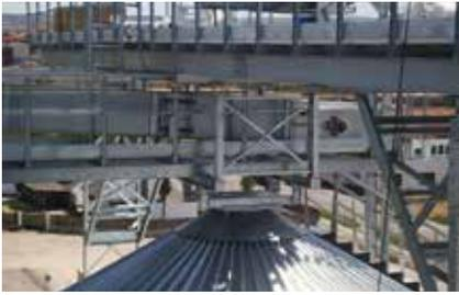
**O suporte de cúpula** serve de apoio à passarela e é colocado por cima da tampa superior do teto do silo. Existem diferentes tipos em função do rendimento da maquinaria e do tipo de passarela.
