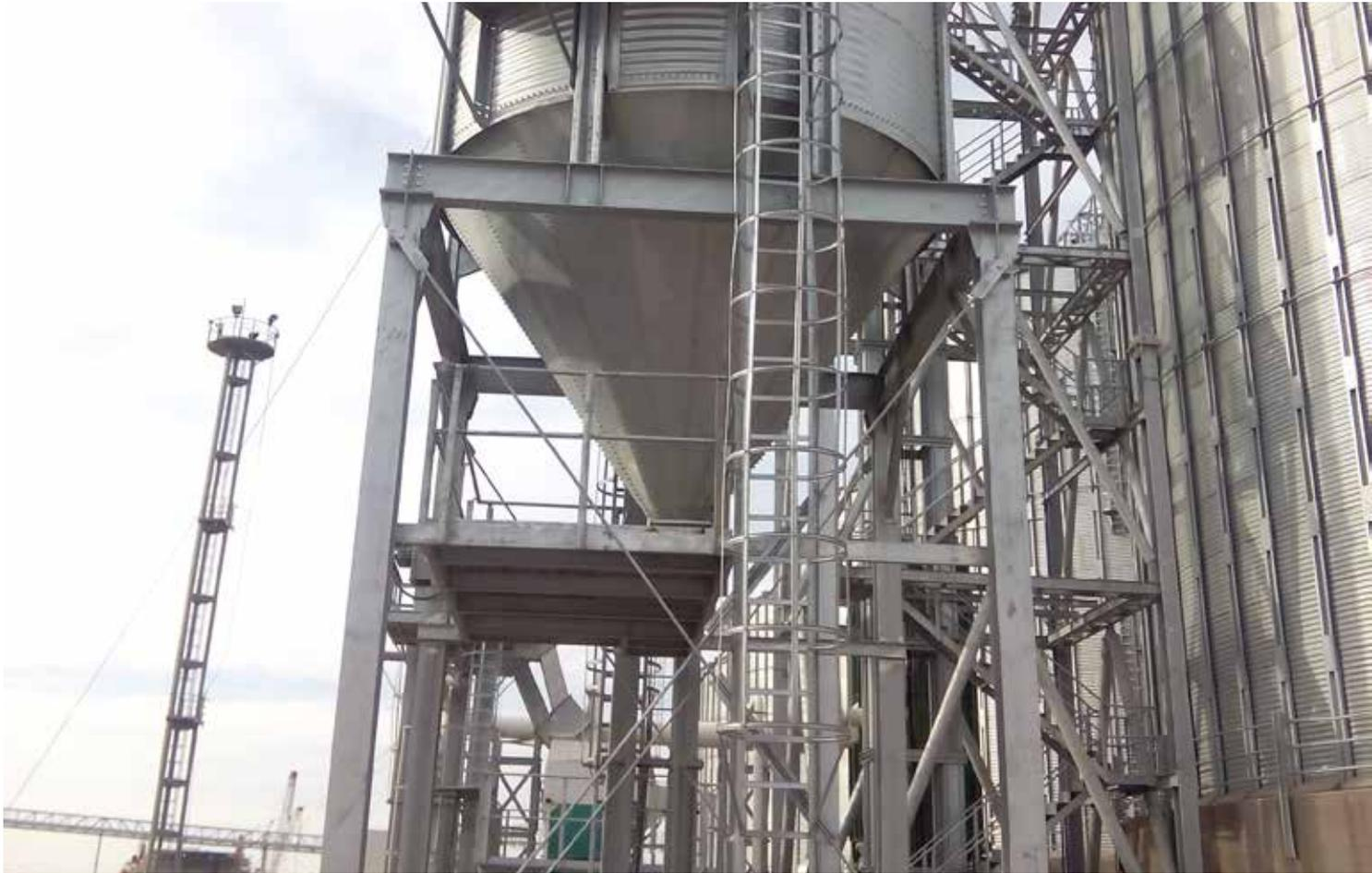
Os silos de carga a granel sobre estrutura foram concebidos para armazenamento e posterior envio de produtos a granel como granulados, farinhas, etc...
