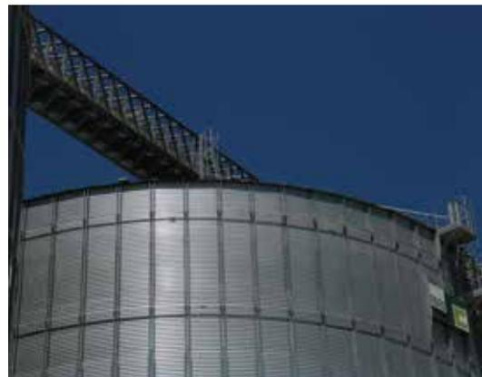
O **Anel de Vento** permite que o silo conserve a sua forma cilíndrica sem ser afetado pelas cargas de vento, conferindo rigidez e segurança. Dependendo do diâmetro e da altura do silo, podem ser colocados no teto ou no anel.
