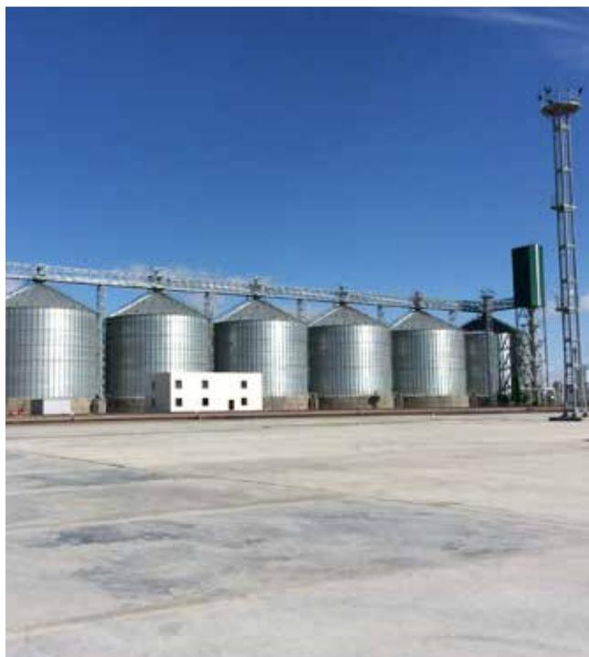
Os nossos silos com corpo cilíndrico e teto inclinado a 30° destinam-se ao armazenamento de grãos, sementes e outros produtos. A equipe de engenharia da Silos Córdoba projeta os seus silos de acordo com diferentes normas, de forma a adaptar-se às necessidades dos seus clientes, entre as quais destacamos a norma europeia EUROCODIGO e a norma americana ANSI.
