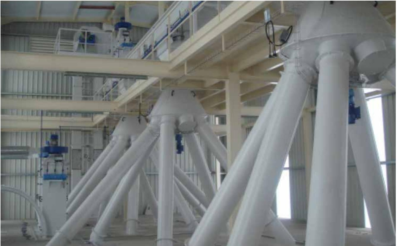
Con una inclinación de 45-60°, contruidos en chapa de acero de 3 mm. La parte superior, en chapa de 4 mm. El cono en el desviador inferior y en 6 mm. El conducto rotativo interior. Accionados mediante motorreductor de engranajes de 0,25 cv. con freno, lo que asegura un perfecto posicionamiento del conducto interior en la boca deseada.
