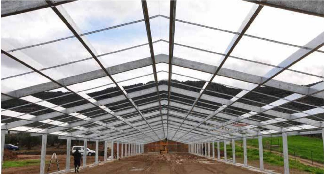
Dadas las necesidades de las instalaciones avícolas se hace necesaria una edificación totalmente diáfana con objeto de eliminar barreras, proporcionar una ventilación adecuada y tener una iluminación homogénea. Se ha considerado como sistema idóneo para resolver estas necesidades una estructura metálica a base de pórticos y dinteles sin apoyos intermedios.
