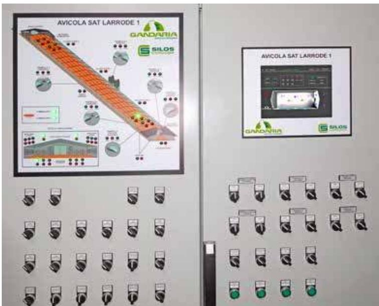
El control de una granja es fundamental para el buen funcionamiento de la misma, debe de ser fiable, completo y tener comunicaciones para el visionado y cambio de parámetros desde dispositivo remoto. Gandaria cuenta con una amplia gama para satisfacer todas las necesidades, además proporcionan estadísticas y consumos de agua y pienso.
